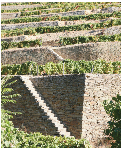
Les anciennes terrasses murées de la quinta de Terra Feita
