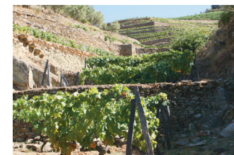
Renova do Depósito
